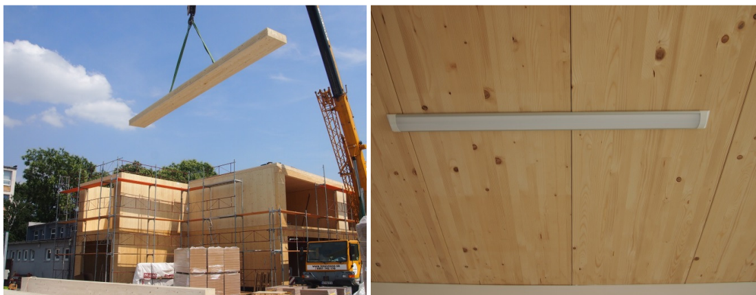
4 - Montáž strechy a konečný vzhľad z interiéru
