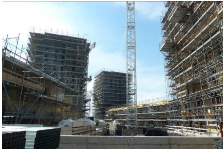
Obr. 4 Montáž tepelnej izolácie
