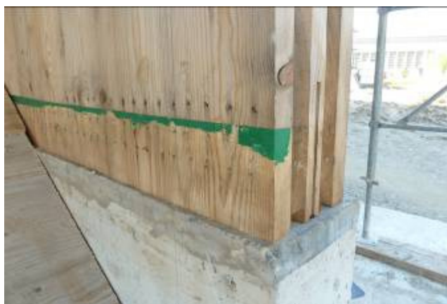
Obr. 7 Prípoj stena - základ
