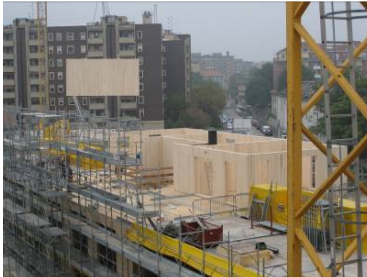
Obr. 3 Montáž stenových elementov
