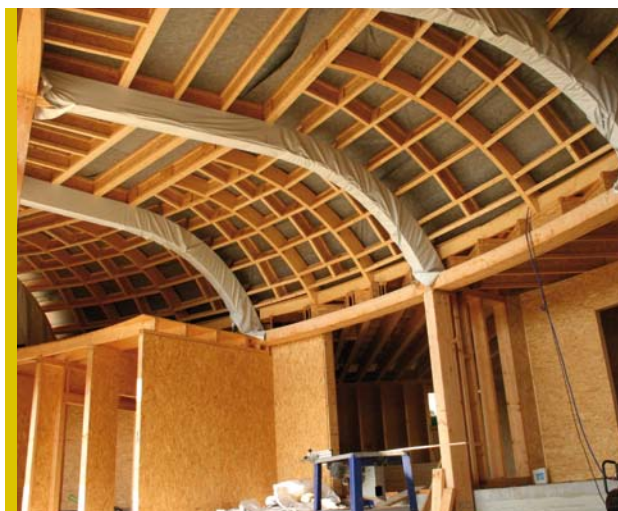
Obr. 6 Strecha nad oblúkovou časťou
