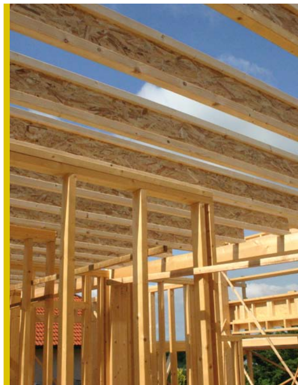
Obr. 5 Nosníky Steico v plochej časti strechy
