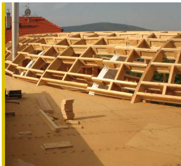
Obr. 11 Montáž strešných vrstiev
