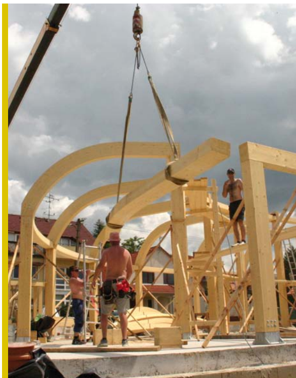
Obr. 4 Začiatok montáže rámov z lepeného lamelového dreva
