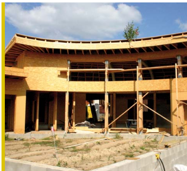
Obr. 10 Vnútorňá terasa – základy
