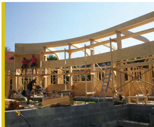
Obr. 7 Obkladanie a zároveň vystužovanie zakrivených plôch
