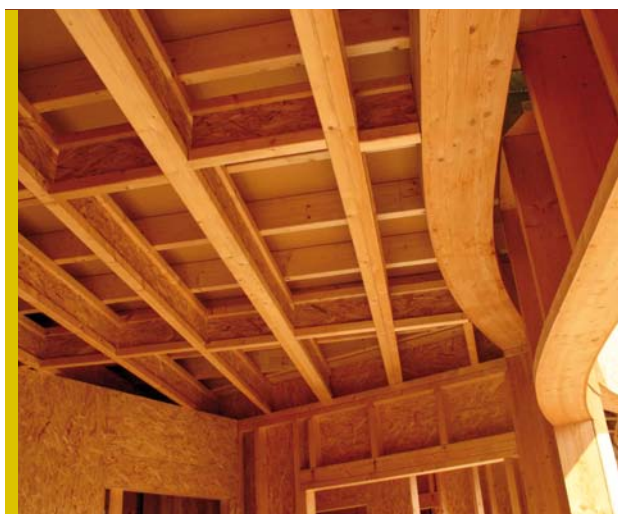
Obr. 8 Nosná konštrukcia plochej strechy
