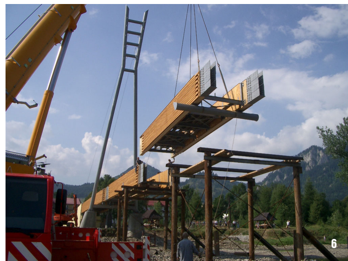
5 - Lávka cez Dunajec, Červený Kláštor - celkový pohľad a schéma; 6 - Montáž predpripravených úsekov lávky
