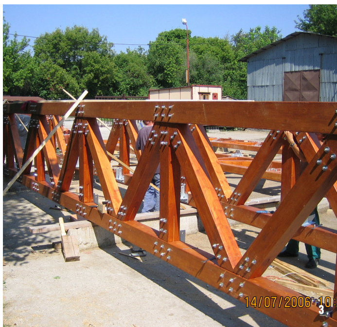
3 - Rybársky Dvor, Piešťany - montáž mosta u dodávateľa; 4 - Osadenie troch v dielni zhotovených mostov prebehlo počas jedného dopoludnia
