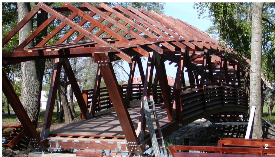
2 - Vstup na letné kúpalisko, Nové Zámky - lávka bez krytiny
