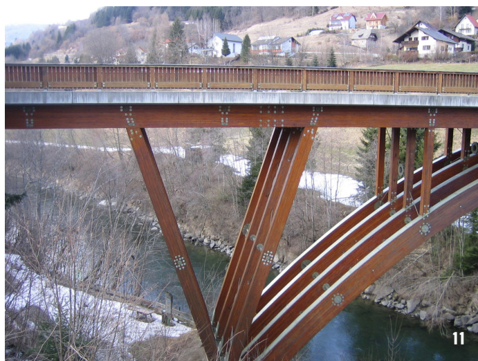
10 – Most St. Georgen-St. Lorenzen; 11 – Oblúky, podpory a hlavné nosníky sú z dreva červeného smreka, mostovka je železobetónová spriahnutá s hlavnými nosníkmi, výstužný systém mosta je z ocelových prvkov
