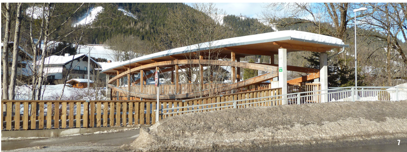
7 - Most cez Enns, Schladming - celkový pohľad z pravého brehu, portál je tvorený dvoma železobetónovými stĺpmi
