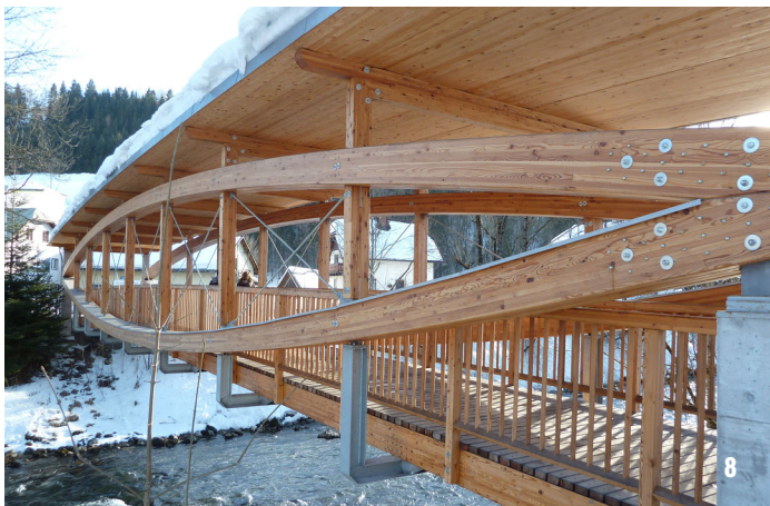
8 - Most cez Enns, Schladming - v spodnej časti je zreteľný oceľový polrám, ktorý je zavesený na spodnom páse; 9 - Drevo na moste pôsobí veľmi príjemne a priateľsky
