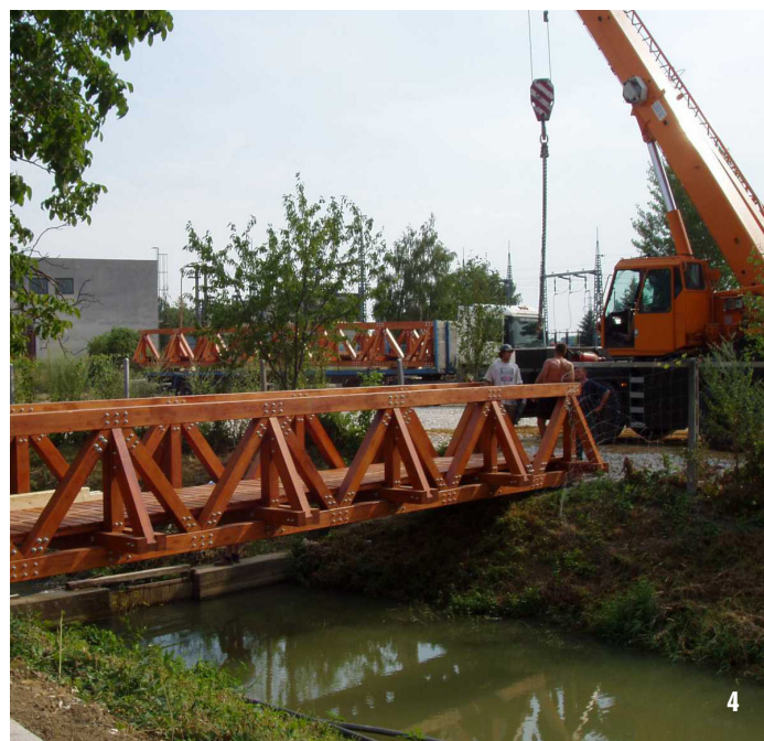
3 - Rybársky Dvor, Piešťany - montáž mosta u dodávateľa; 4 - Osadenie troch v dielni zhotovených mostov prebehlo počas jedného dopoludnia
