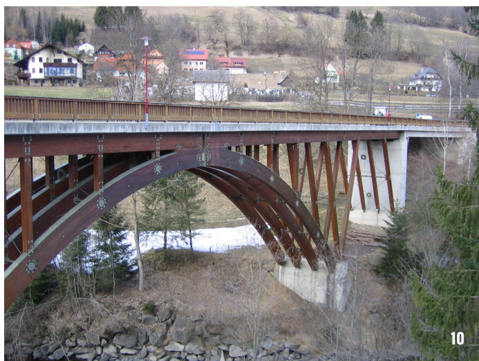
10 – Most St. Georgen-St. Lorenzen; 11 – Oblúky, podpory a hlavné nosníky sú z dreva červeného smreka, mostovka je železobetónová spriahnutá s hlavnými nosníkmi, výstužný systém mosta je z ocelových prvkov
