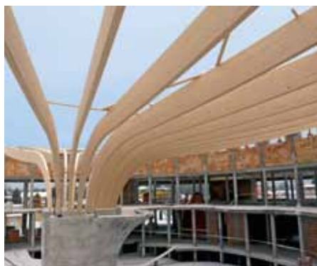
Obr. 3a, 3b a 3c: Nosná strešná konštrukcia bazénu a promenády, Aquapark Podhájska 2010, foto: František Lužica, Tectum Novum
