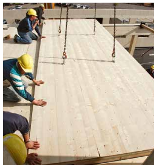
Obr. 11: Montáž stien a stropov z CLT, foto Proholz
