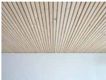
Obr. 4: Nastojato uložené dosky spojené mechanickými spojovacími prostriedkami (BRESTA) ako stropná doska (vľavo), priečne predpätá drevená mostovka (vpravo)
