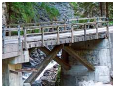
Obr. 4: Nastojato uložené dosky spojené mechanickými spojovacími prostriedkami (BRESTA) ako stropná doska (vľavo), priečne predpätá drevená mostovka (vpravo)
