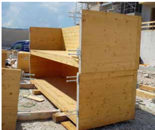
Obr. 12: Predpripravená konštrukcia balkóna bytového domu pripájaná pomocou vlepaných tyčí, projekt L'Aquila, foto: Proholz
