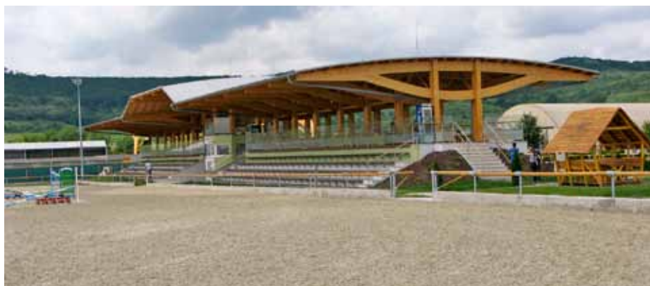
Obr. 2: Veľká tribúna v jazdeckom areáli v Pezinku, zhotovená v roku 2010, je súčasťou komplexu drevených konštrukcií – 2 tribúny, jazdecká hala s rozpätím 37 metrov, stajňa, boxy pre 250 koní a altánky pre návštevníkov
