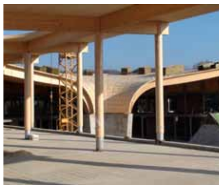
Obr. 3a, 3b a 3c: Nosná strešná konštrukcia bazénu a promenády, Aquapark Podhájska 2010, foto: František Lužica, Tectum Novum
