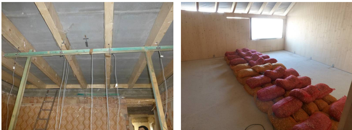
Obr. 5 Meranie deformácie stropnej konštrukcie (vľavo) a zaťaženie stropnej konštrukcie (vpravo)
