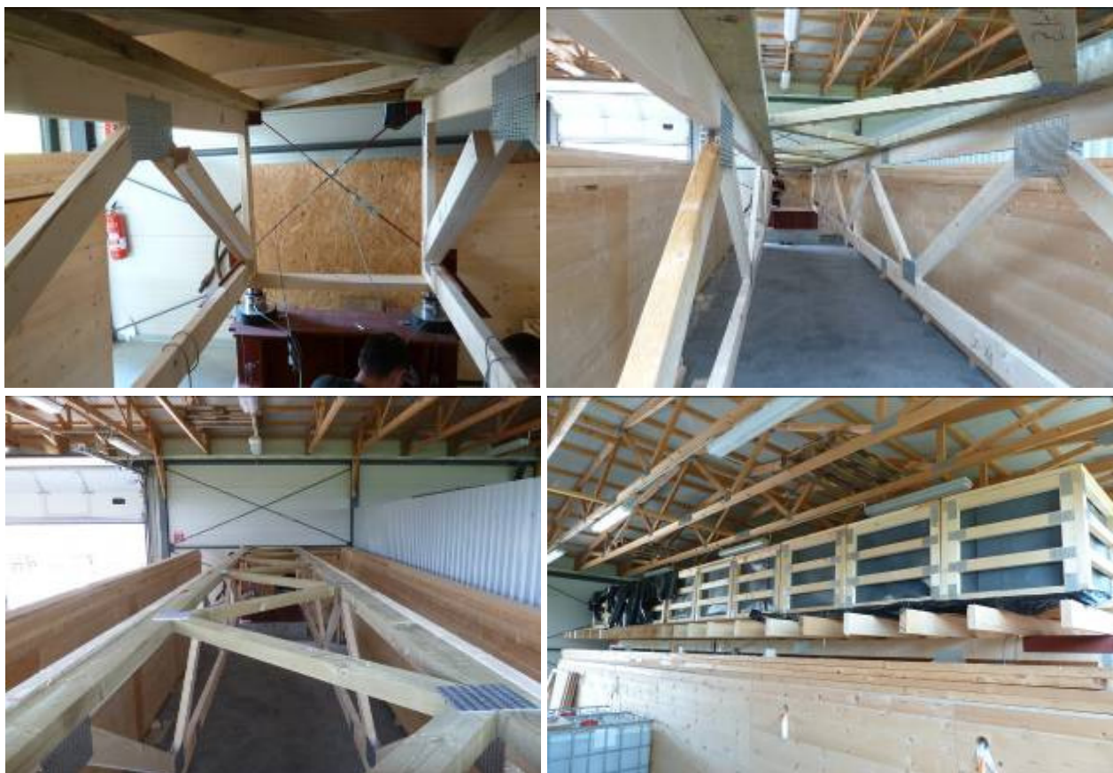
Obr. 1: Skúšobné nosníky a zaťažovacia zostava
