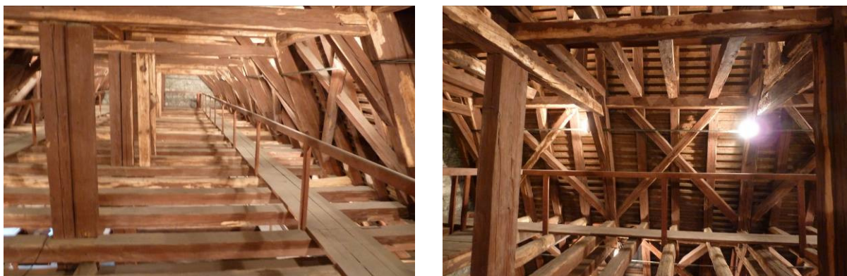
Obr. 1.3 – Nosná konštrukcia krovu nad presbytériom
