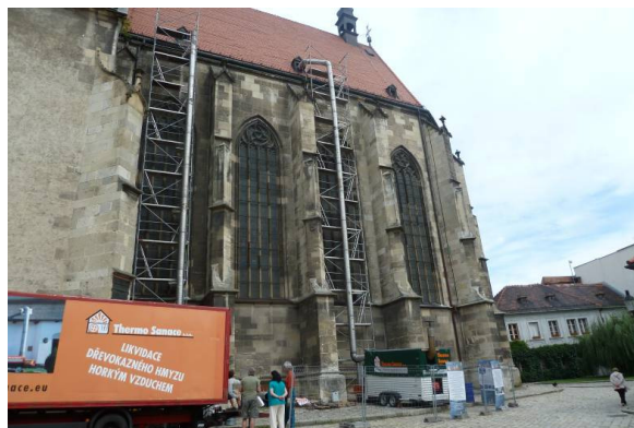
Obr. 1.1 – Pohľad na strešnú konštrukciu a inštalácia vykurovacích agregátov
