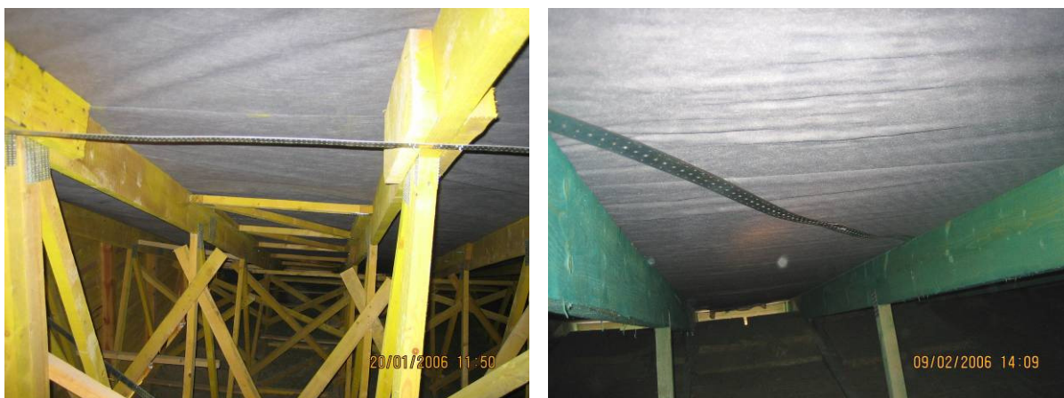
Obr. 5 - Chýbajúci segment vystužovadla a neúčinné (uvoľnené) vystuženie oceľovým pásom
