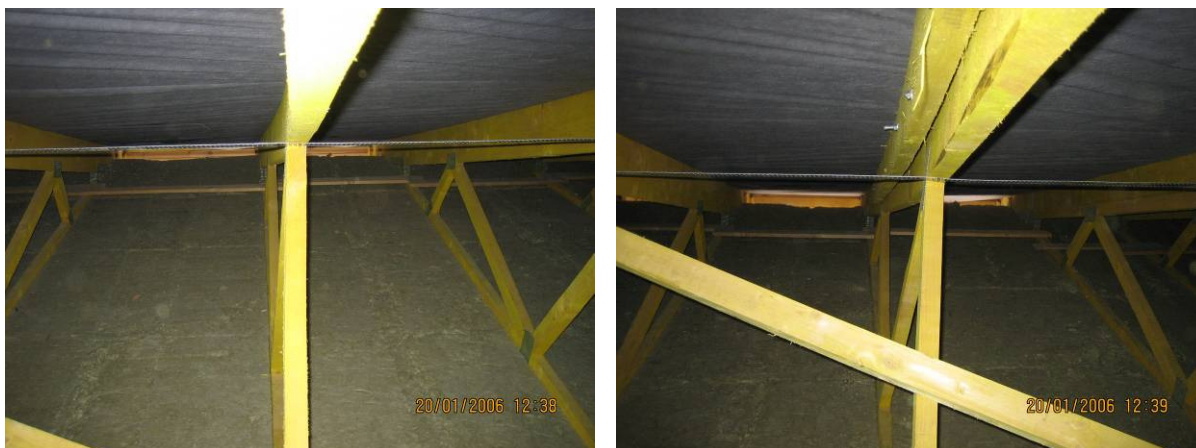
Obr. 4 - Nedostatočne stabilizovaný (vybočený) tlačný pás väzníka
