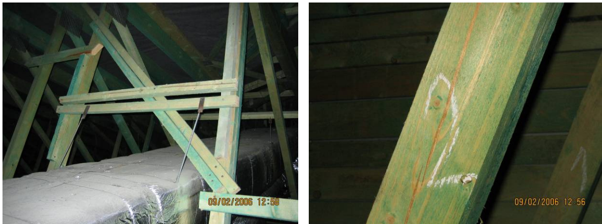
Obr. 3 - Neodborné zásahy do nosnej konštrukcie a vady materiálu
