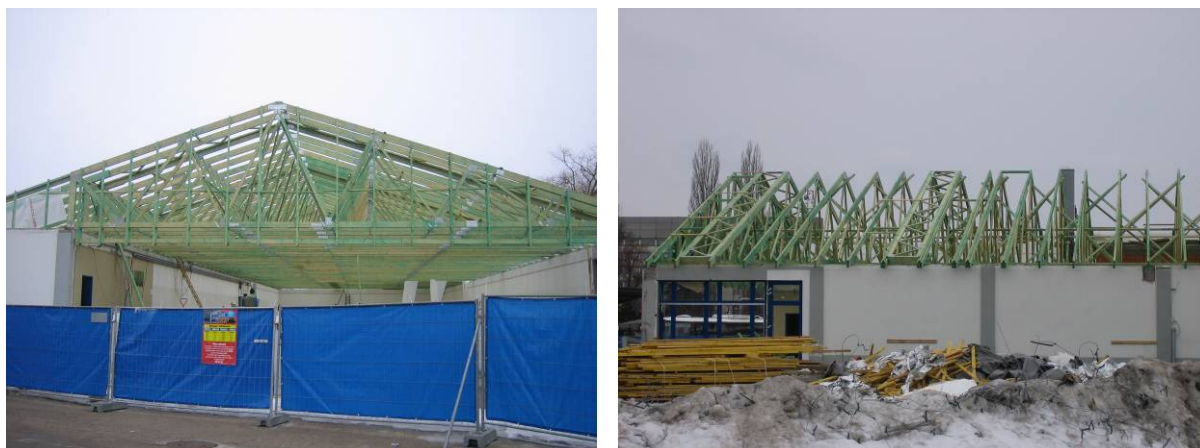
Obr. 1 - Montáž strešnej konštrukcie z drevených väzníkov
