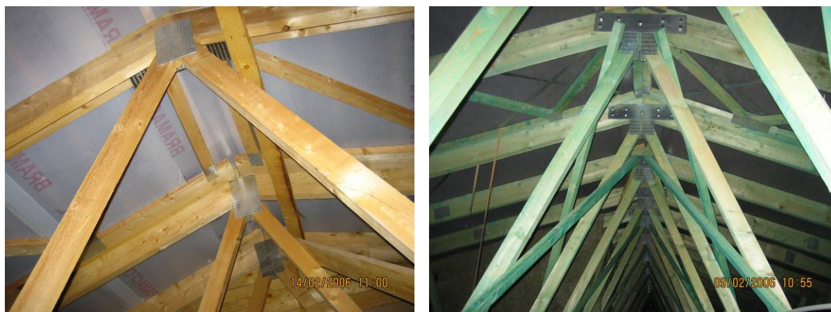
Obr. 2 - Priehradový väzník so styčnicami s oceľovými doskami s prelisovanými tŕňmi
