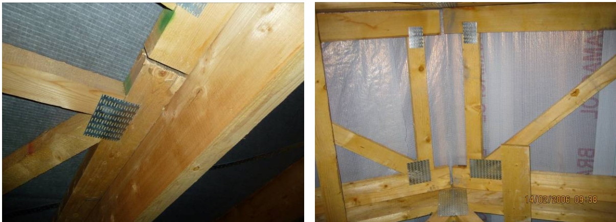
Obr. 6 - Neprepojené segmenty priečneho strešného vystužovadla
