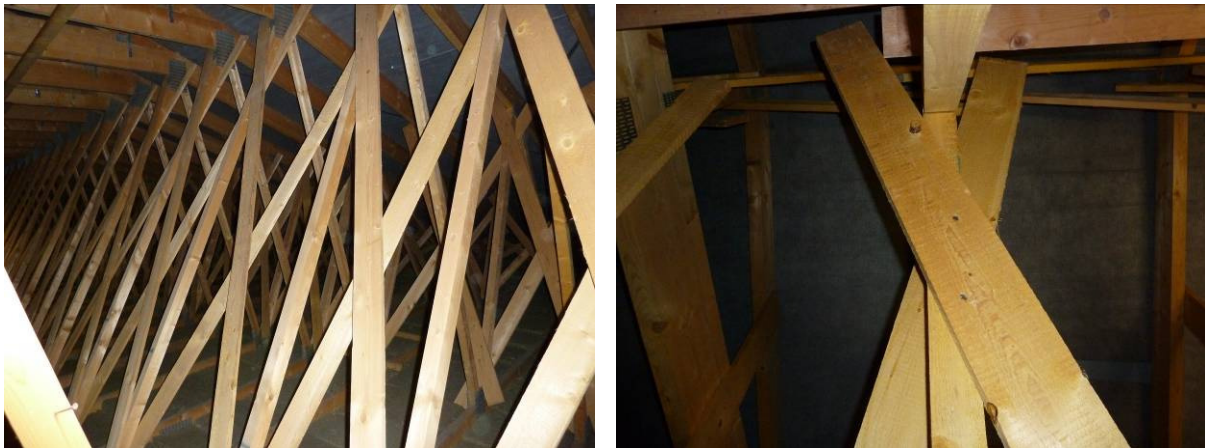
Obr. 8 - Štíhle (neúčinné) prúty pozdĺžneho vystužovadla a nedostatočný prípoj
