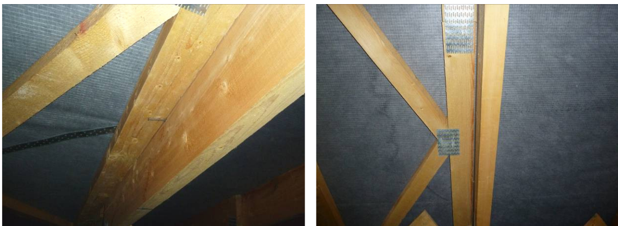
Obr. 7 - Nedostatočné pripojenie vystužovadla k pásom priehradového väzníka
