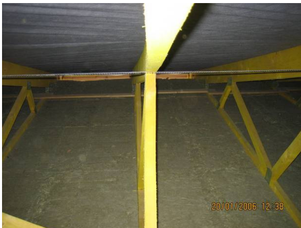
Obr. 4 - Nedostatočne stabilizovaný (vybočený) tlačný pás väzníka
