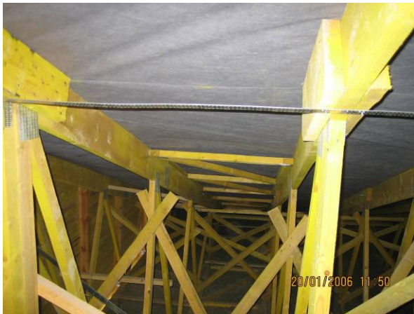
Obr. 5 - Chýbajúci segment vystužovadla a neúčinné (uvoľnené) vystuženie ocelovým pásom
