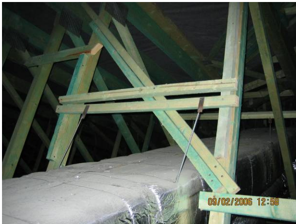
Obr. 3 - Neodborné zásahy do nosnej konštrukcie a vady materiálu
