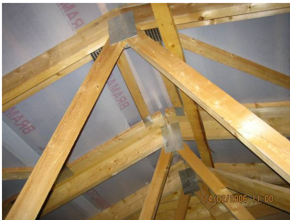
Obr. 2 - Priehradový väzník so styčnicami s ocelovými doskami s prelisovanými trňmi
