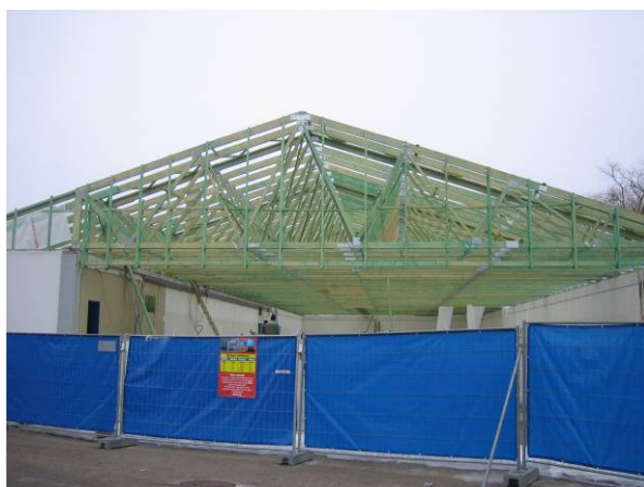
Obr. 1 - Montáž strešnej konštrukcie z drevených väzníkov
