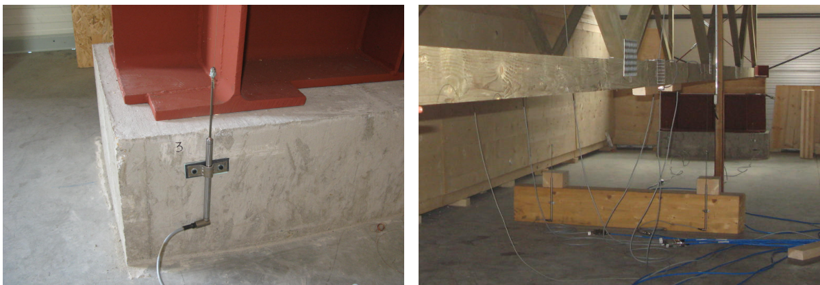
Obr. 8 – Meranie deformácií v mieste podpery a v strede rozpätia nosníka
