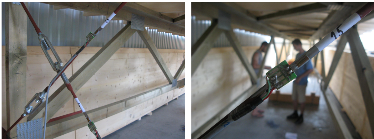
Obr. 12 – Osadenie tenzometrov na oceľových vystužovadlách
