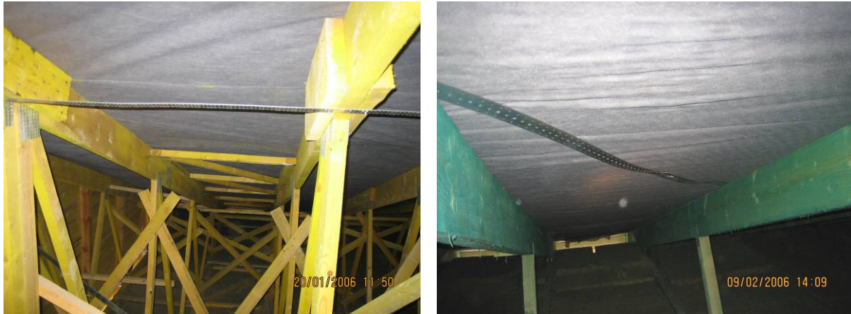
Obr. 5 - Chýbajúci segment vystužovadla a neúčinné (uvolnené) vystuženie ocel'ovým pásom
