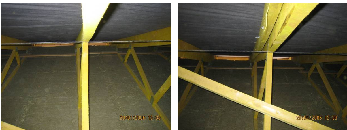
Obr. 4 - Nedostatočne stabilizovaný (vybočený) tlačný pás väzníka
