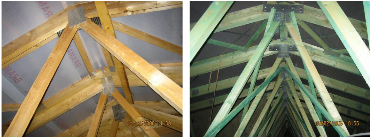
Obr. 2 - Priehradový väzník so styčníkmi s oceľovými doskami s prelisovanými trňmi
