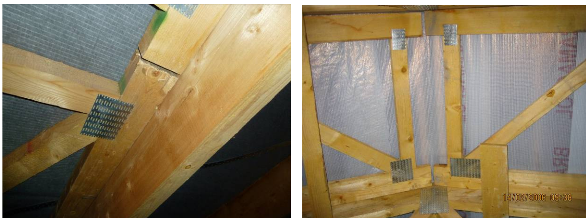
Obr. 6 - Neprepojené segmenty priečného strešného vystužovadla
