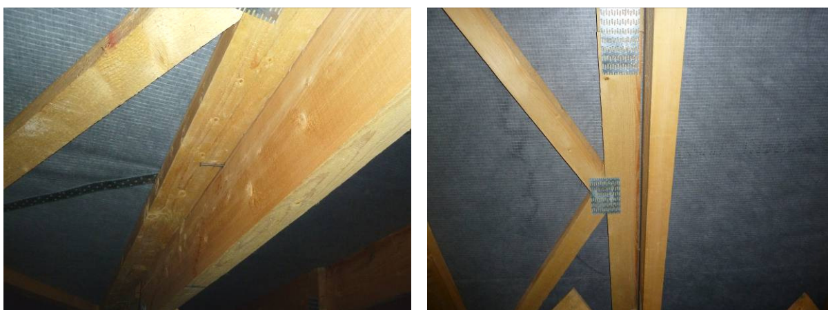
Obr. 7 - Nedostatočné pripojenie vystužovadla k pásom priehradového väzníka
