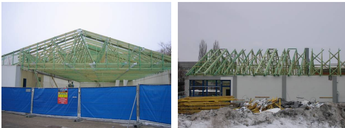
Obr. 1 - Montáž strešnej konštrukcie z drevených väzníkov
