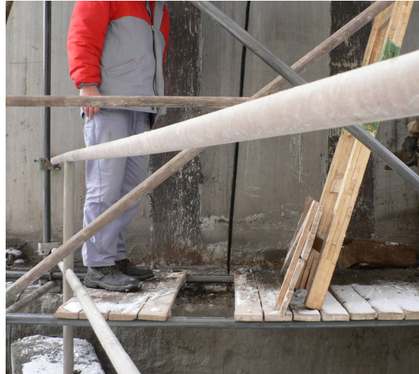
Obr. 3: Pohľad na trhlinu v sila PC2 (november 2005), detail
