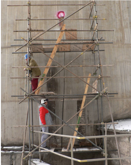
Obr. 2: Pohľad na trhlinu v sila PC2 (november 2005)
