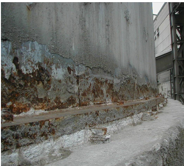
Obr. 6: Súčasný stav kotvenia síla a železobetónových základových konštrukcií
