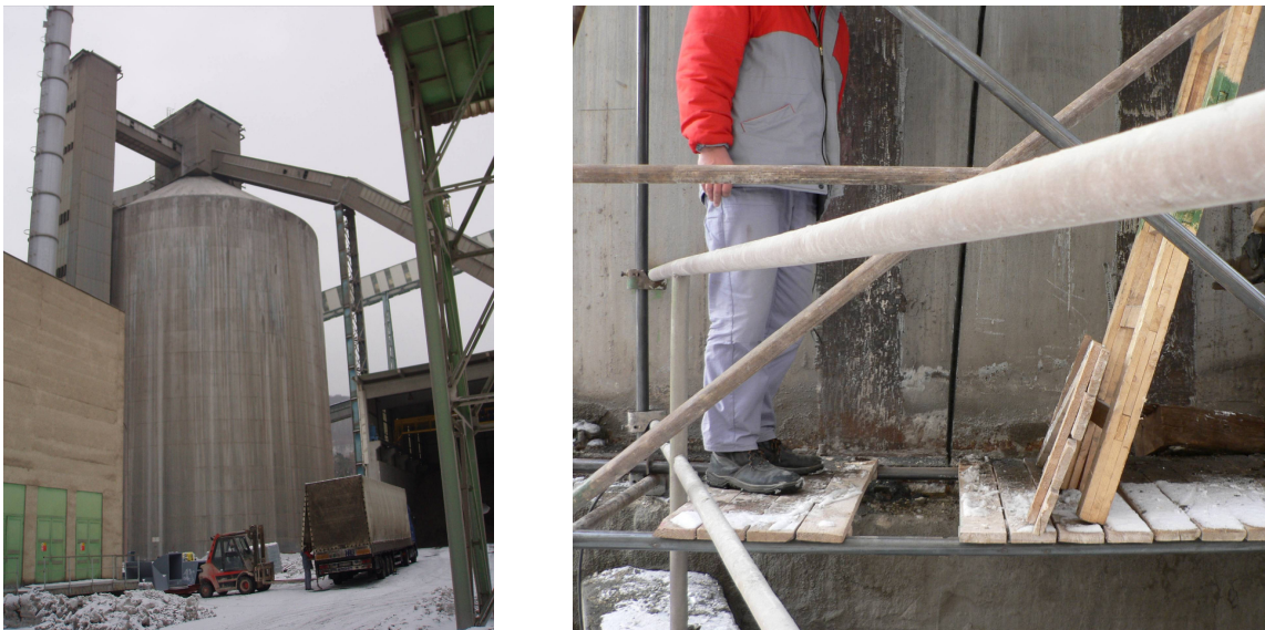
Obr. 5 Pohľad na slinkové silo PC2 s technológiou a pohľad na trhlinu v sile PC2 (november 2005)
