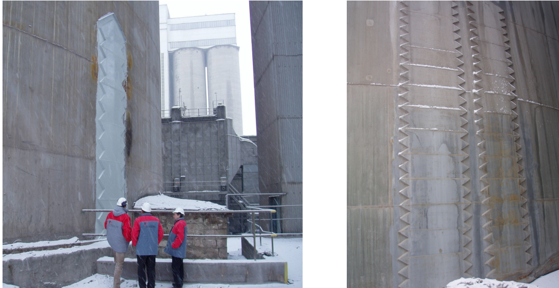
Obr. 6 Pohľad na zrealizované opravy v mieste porúch slinkového sila PC2
