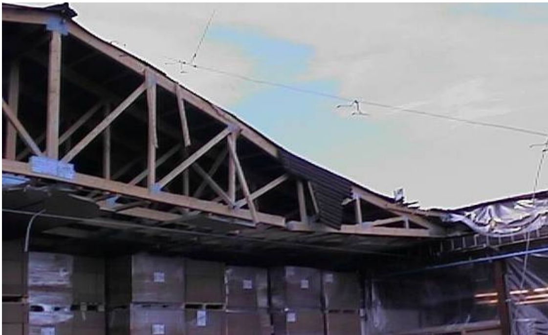
Obr. 2 – Porušenie väzníka
