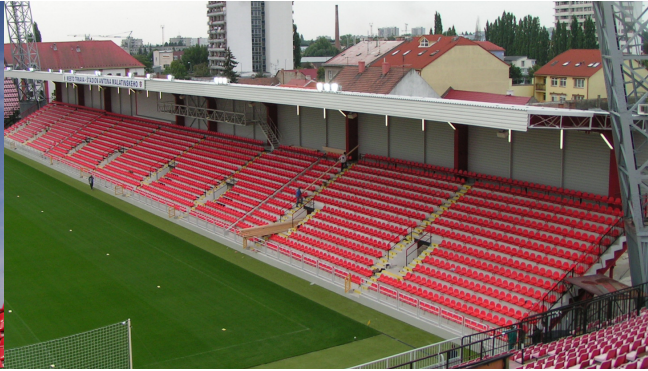
Obr. 15: Pohľad na rekonštruovanú strechu
