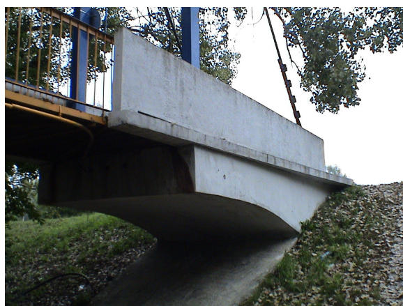
Obr. 4 – ŽB kotevný blok
