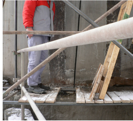
Obr. 17: Pohľad na trhlinu v síle PC2 (november 2005), detail
