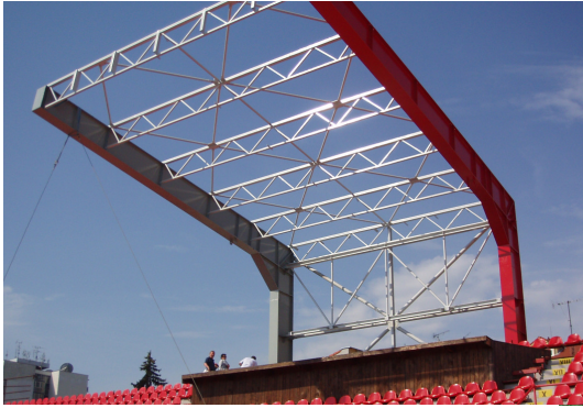
Obr. 14: Montáž nových konzol
