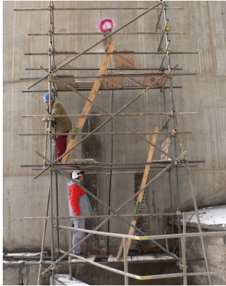
Obr. 16: Pohľad na trhlinu v síle PC2 (november 2005)
