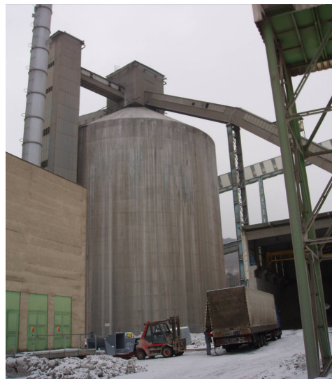
Obr. 1: Pohľad na slinkové silo PC2 s technológiou
