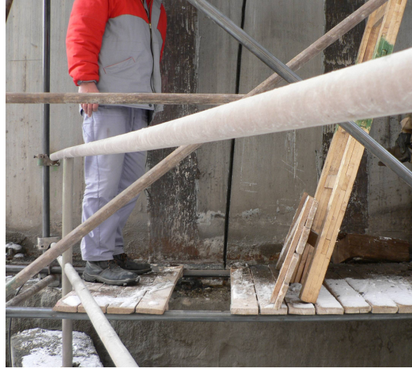
Obr. 3: Pohľad na trhlinu v sile PC2 (november 2005), detail
