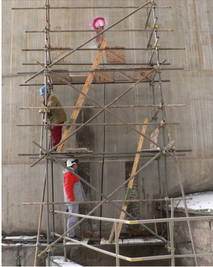
Obr. 2: Pohľad na trhlinu v sile PC2 (november 2005)
