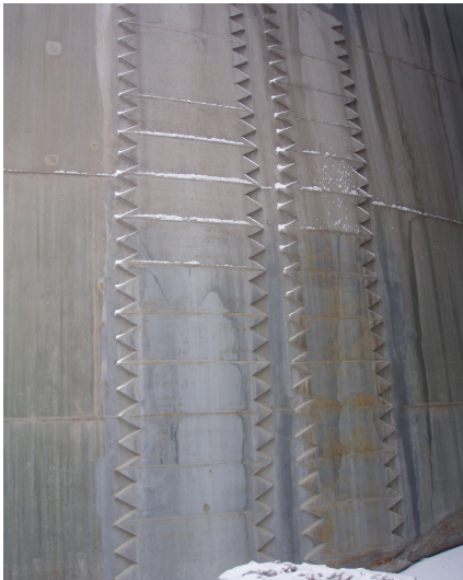
Obr. 4: Pohľad na zrealizovanú opravu v mieste poruchy slinkového sila PC2
