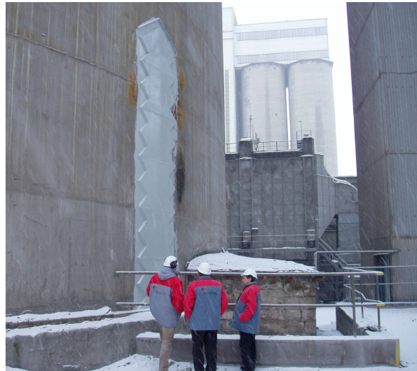
Obr. 5: Pohľad na zrealizovanú opravu v mieste poruchy slinkového sila PC1
