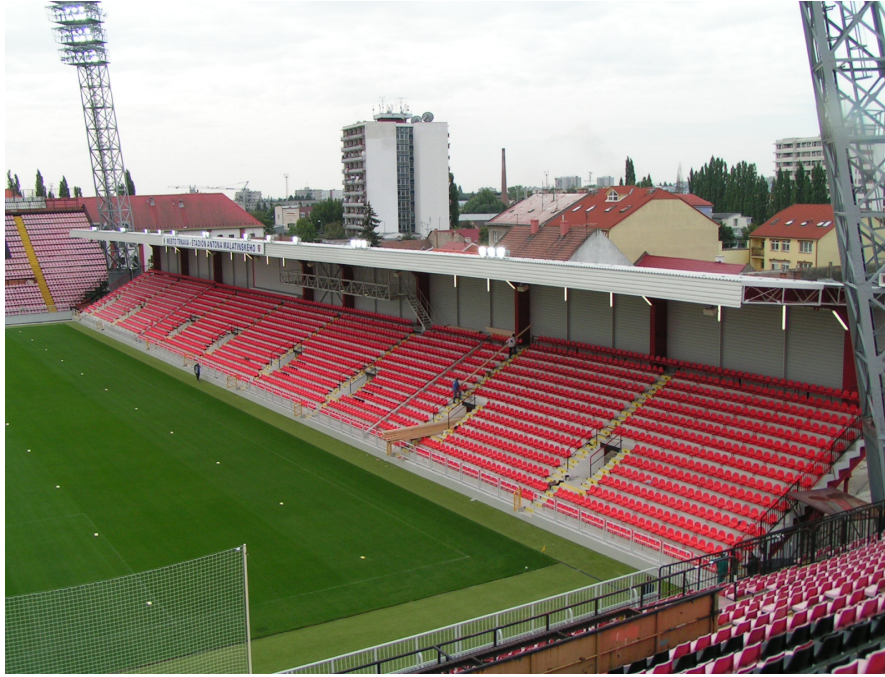
Obr. 7 Pohľad na nové zastrešenia západnej
