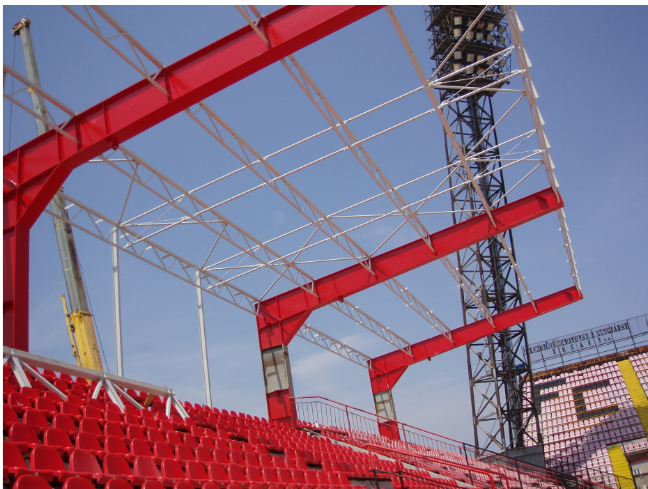
Obr. 6 Montáž oceľovej koštruktúry zastrešenia
