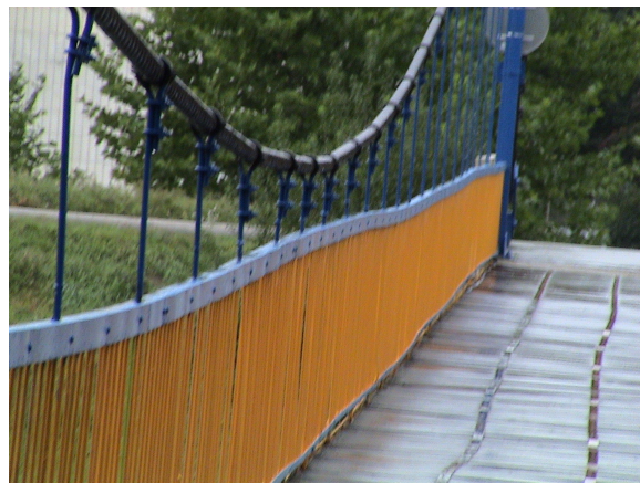
Obr.5 Nepravidelný tvar mostovky a zábradlia.
