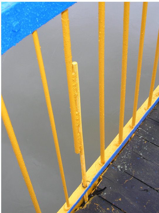
Obr. 10 Nevhodné stykovanie nosných závesov
