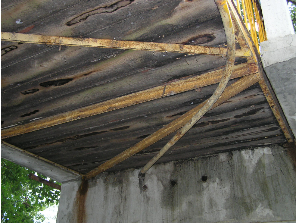
Obr. 12 Kostra mostovky lávky a drevená podlaha
