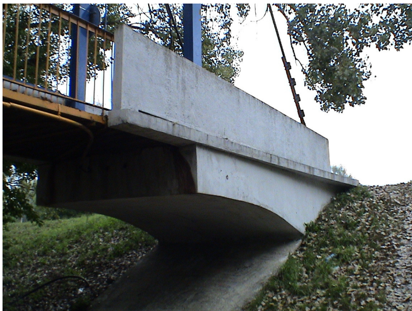
Obr. 2 Železobetónový kotevný blok lávky
